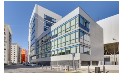
Büro Le Virage | Marseille (F)
