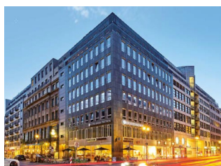
Büro / Geschäftshaus Kontorhaus | Berlin (DE)
